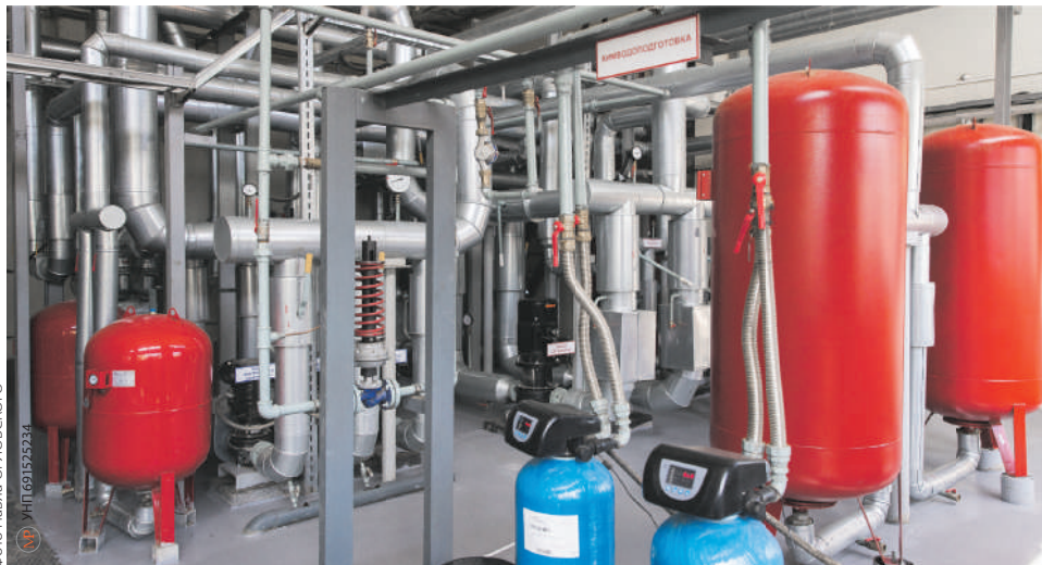
В деревне Кривая Береза специалисты «Котлоэнергосервис – СМУ» смонтировали котельную на фрезерном торфе. Заказчиком выступил Смолевичское ЖКХ
