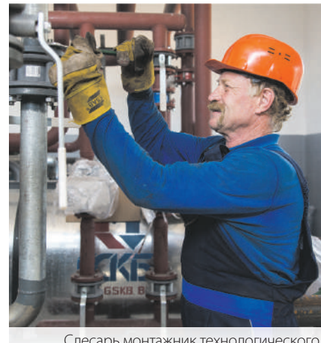
Слесарь-монтажник технологического оборудования и трубопроводов Анатолий Михнюк производит установку арматуры
