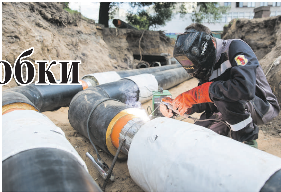
Электросварщик 6-го разряда Михаил Гамолко производит сварку трубопроводов
