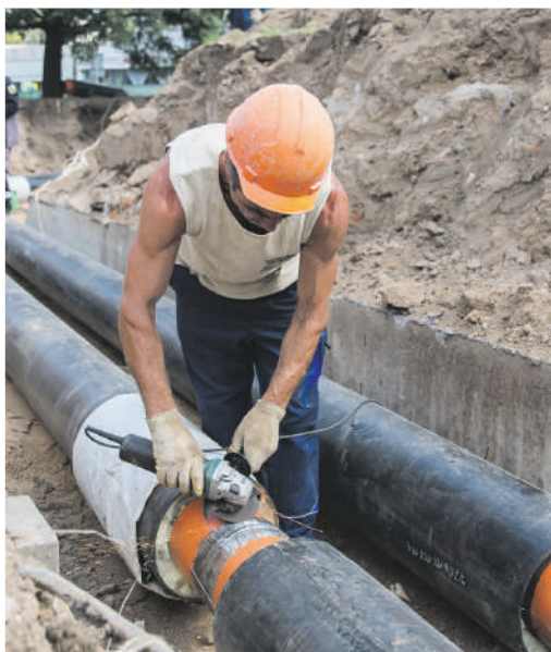
Монтажник 5-го разряда Василий Дунец готовит сварное соединение для ультразвукового контроля
